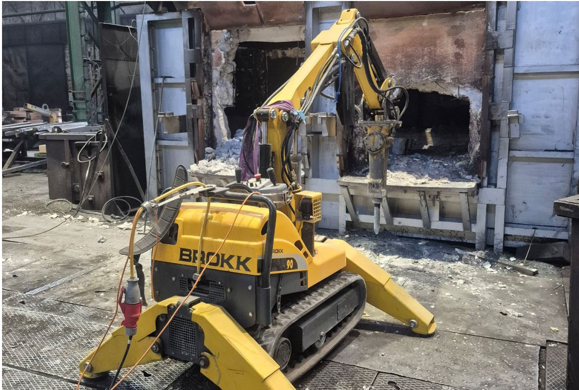
Wyburzanie pieca hartowniczego.
