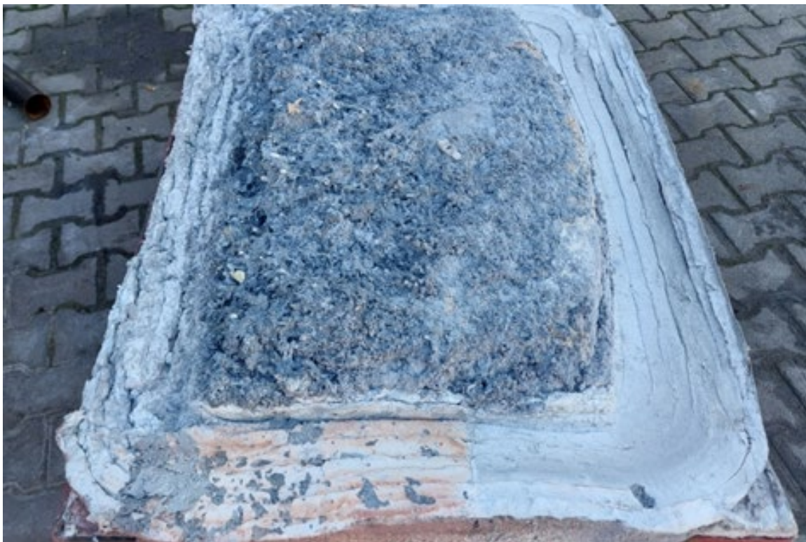
Przed rozpoczęciem prac.
