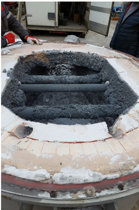
Przed rozpoczęciem prac.
