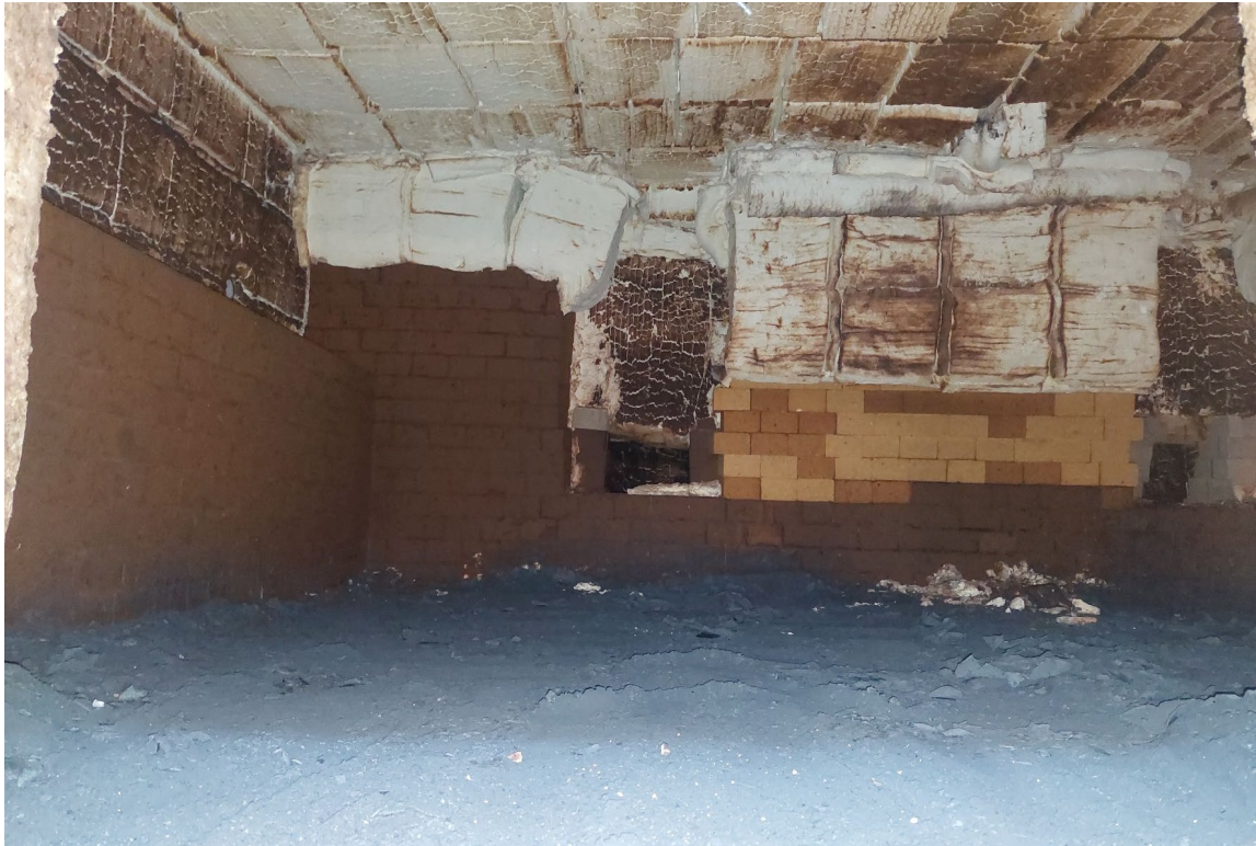
Przed rozpoczęciem prac
