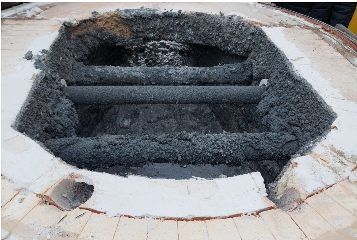
Przed rozpoczęciem prac.
