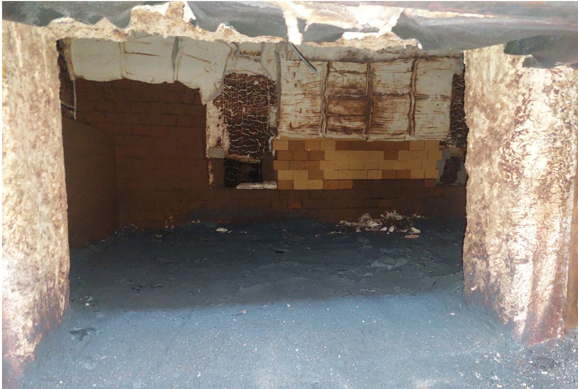
Przed rozpoczęciem prac.
